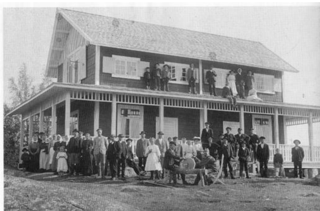
Valtion pitämään Kolin matkailukotin tehtiin toinen kerrus 1908. Kuva on muististehon rakennuksen avajaisista. – T. Ahola.
